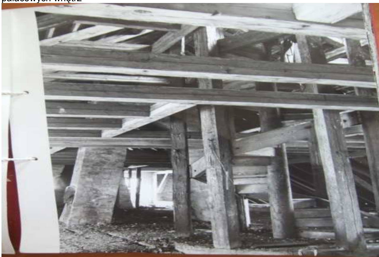
Konstrukcja strychu i więźby dachowej – w głębi widać ciekawy komin tzw. portkowy
